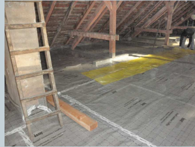
Die (richtige!) Folie gehört unter die Dämmung.
